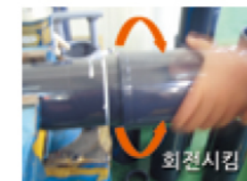
접착제 1차 도포 후 360도 회전하면서 서서히 제로포인트 (Zero Point)까지 삽입 후 신속히 뺐는 작업
